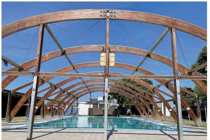
Piscina cubierta (mejoras cerramiento).
